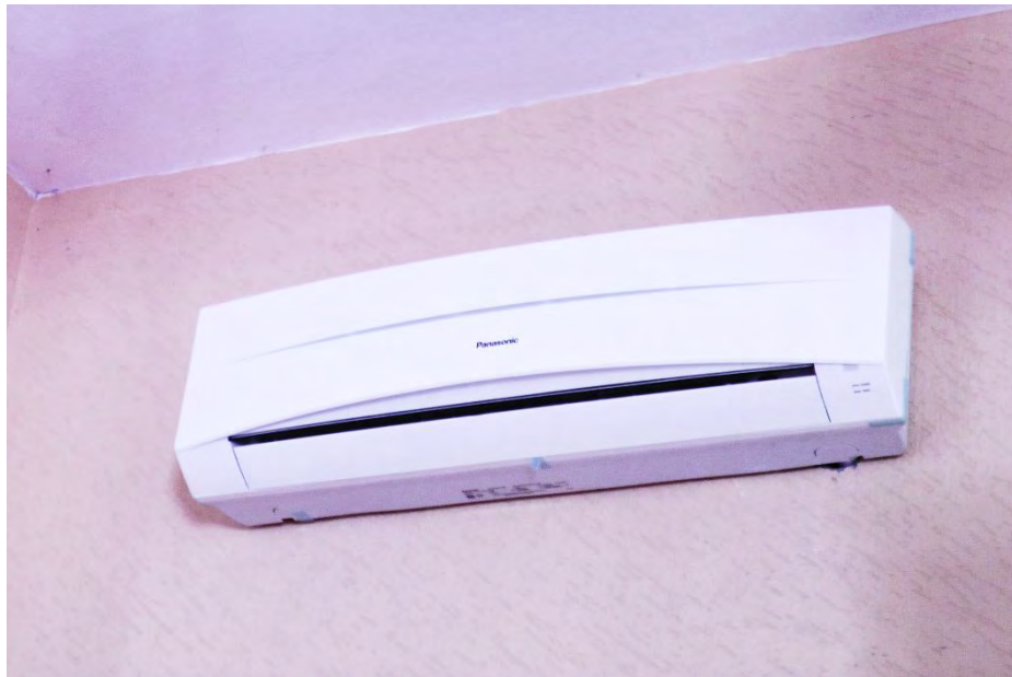
Figura 30. Uno de cuatro Minisplits instalados, marca Panasonic CU-PC18KKQ.
